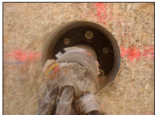
TENDONES OBTURADOS DESPUES DE LA INYECCION
