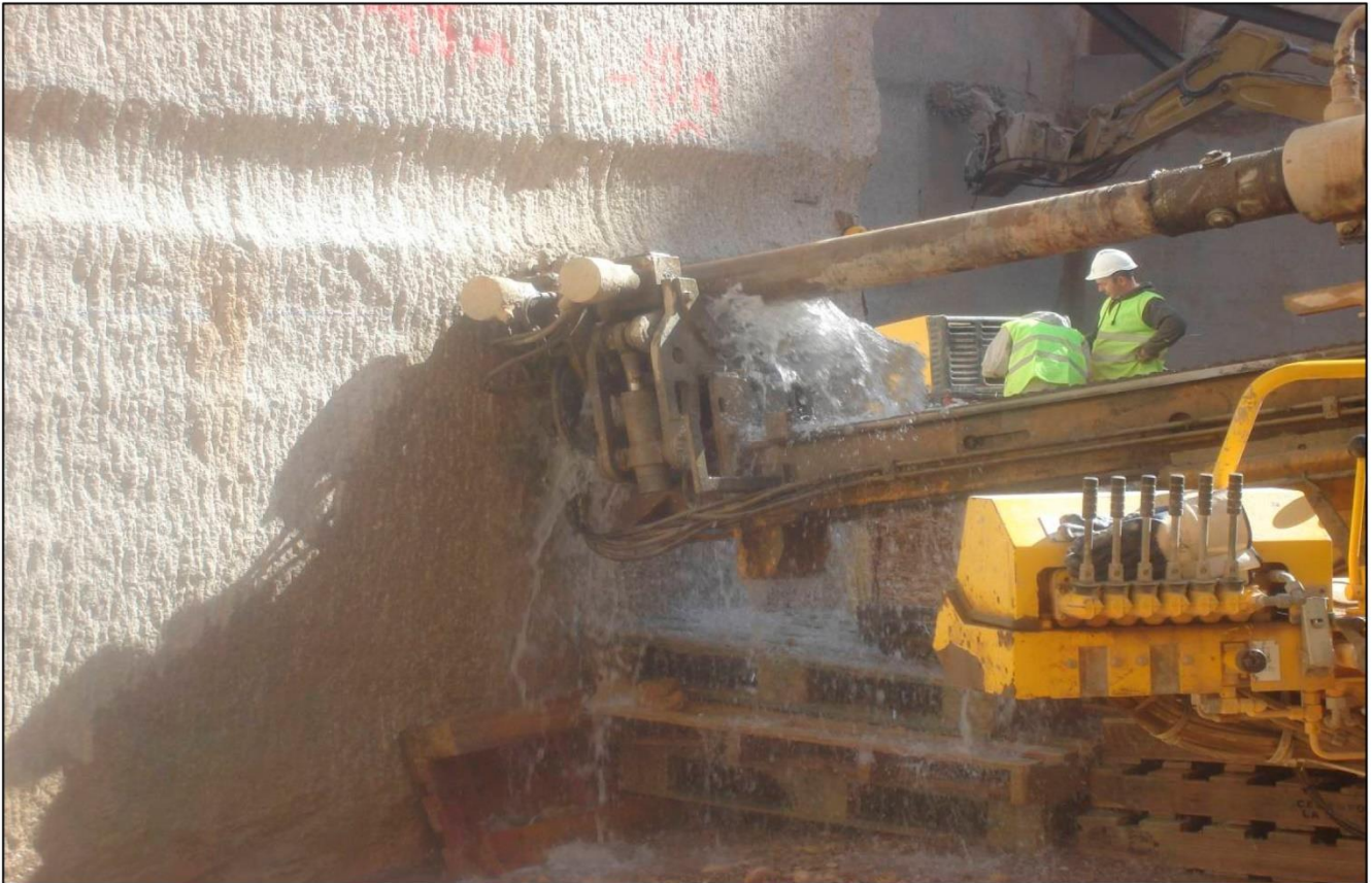
Perforación tendón bajo nivel freático
