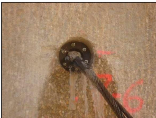
TENDONES OBTURADOS DESPUES DE LA INYECCION
