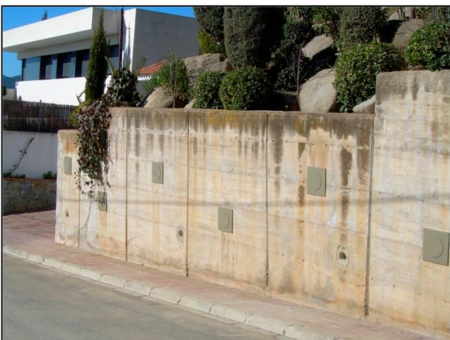
Resultado final muro con anclaje embutido
