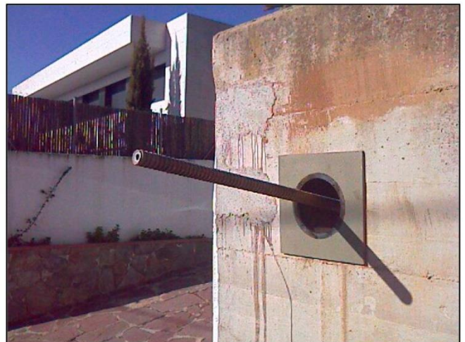
Detalle colocacion barra
