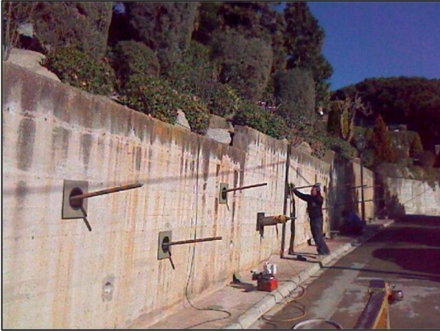
Muro preparado para tesado
