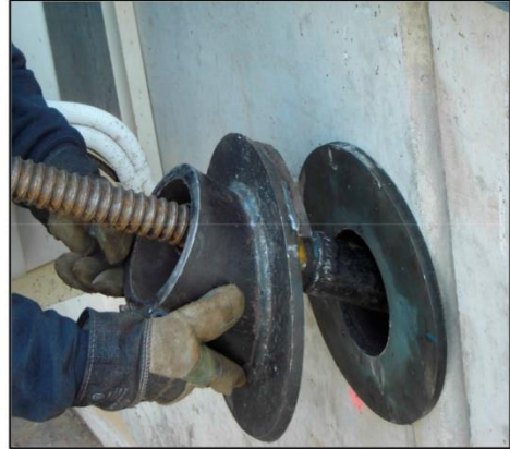
Preparando apoyo para tesado
