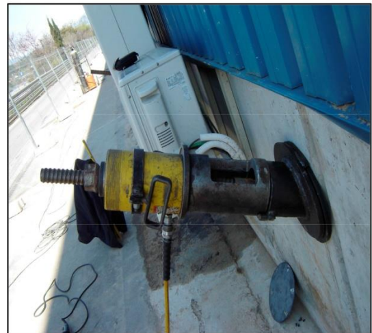
Equipo tesando barra en anclaje embutido
