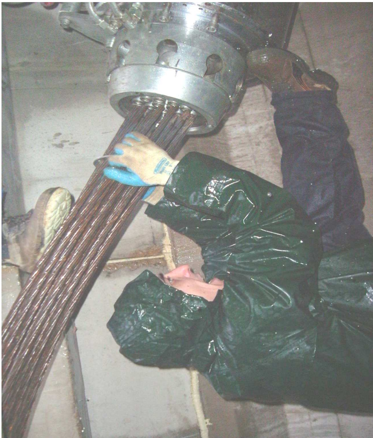
Tensando con Prensa 4.800 kN, 18 cables de 0,6" en la obra de la AUTOVÍA PAMPLONA – IRUN en condiciones climáticas muy desfavorables. (19-01-2009)
